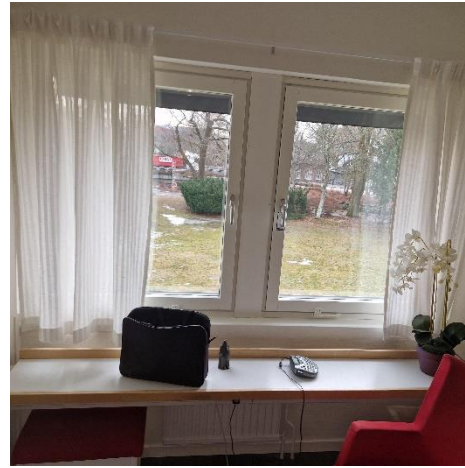
Foto 2 Fönster samt utfackningsväggar är renoverade
